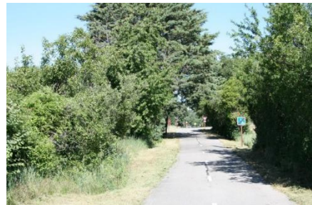
Travaux sur la véloroute du Calavon
